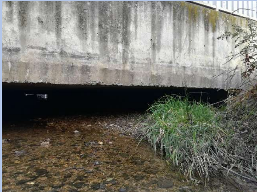
Figure 8 : ouvrage de franchissement vue de l'aval (décembre 2021)
