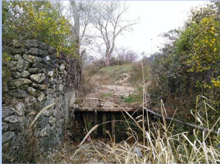
Figure 12 : seuil comblé à traiter (Printemps 2022)
