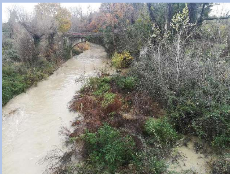
Figure 2 : vue du pont vieux vers l'amont lors d'une crue (décembre 2022)
