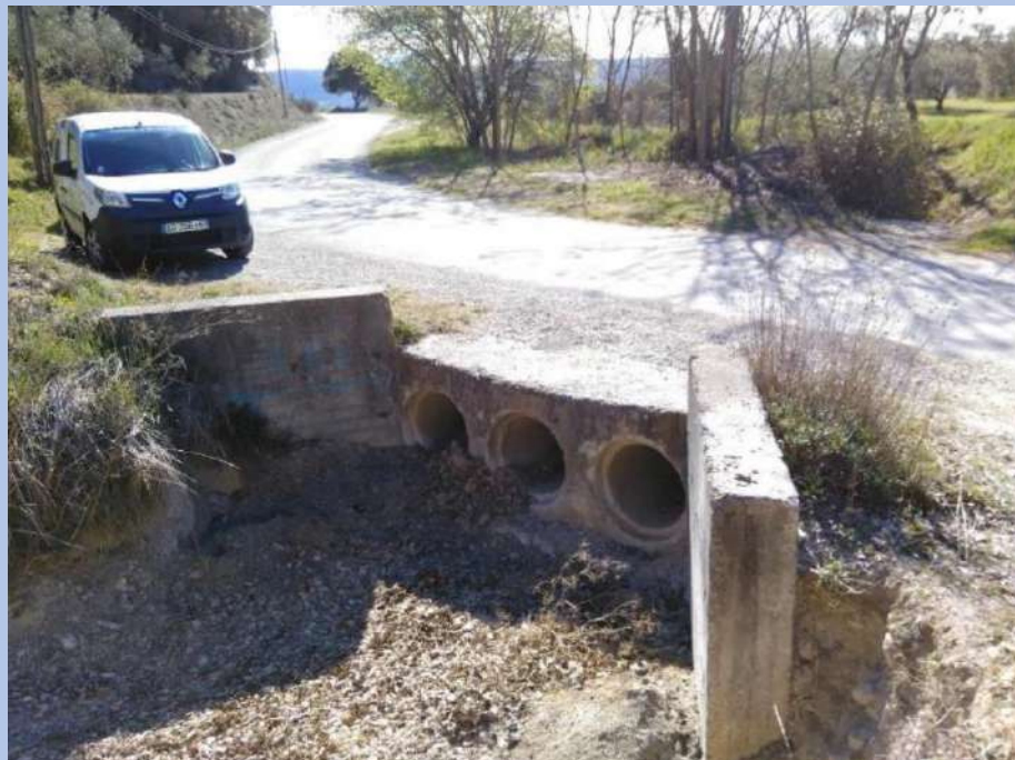
Figure 11 : ouvrage de franchissement vu du chemin de Piétramal (Printemps 2022)
