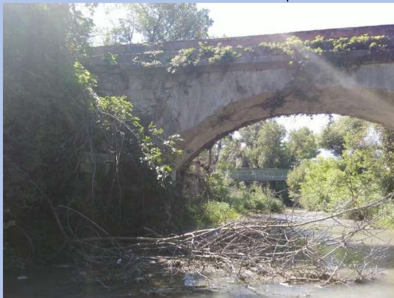
Figure 1 : vue de l'aqueduc de l'atterrissement en rive gauche (printemps 2022)
