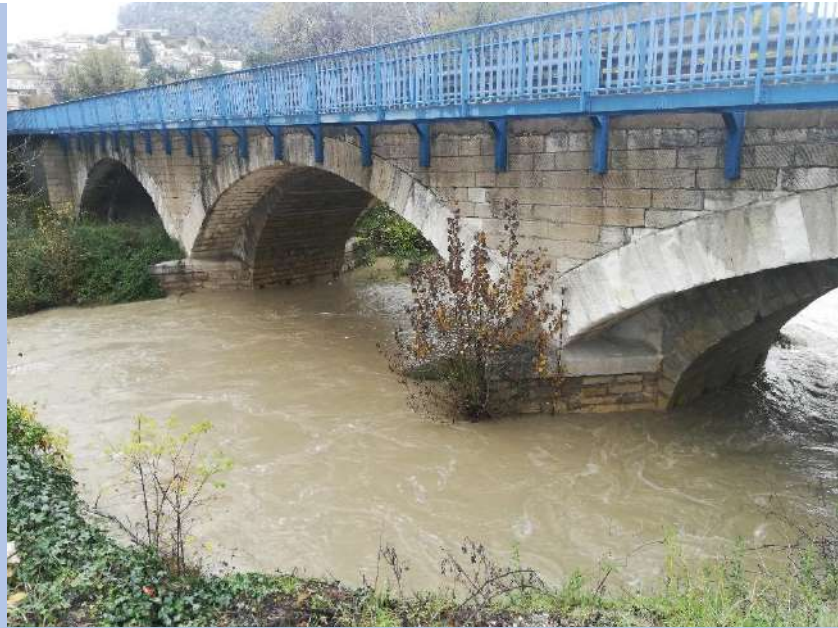
Figure 5 : vue des écoulements en crue sous le pont (décembre 2022)
