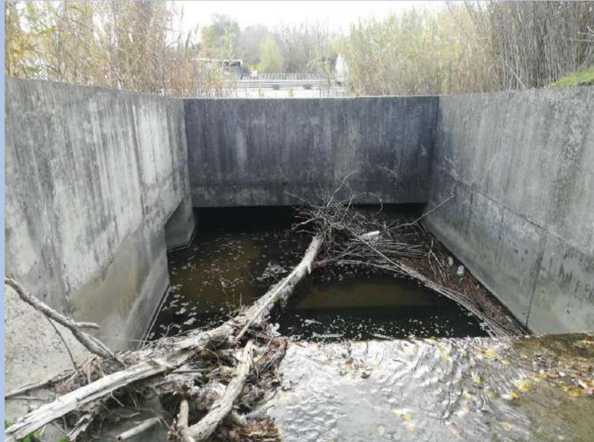
Figure 7 : ouvrage de franchissement vue de l'amont (décembre 2021)
