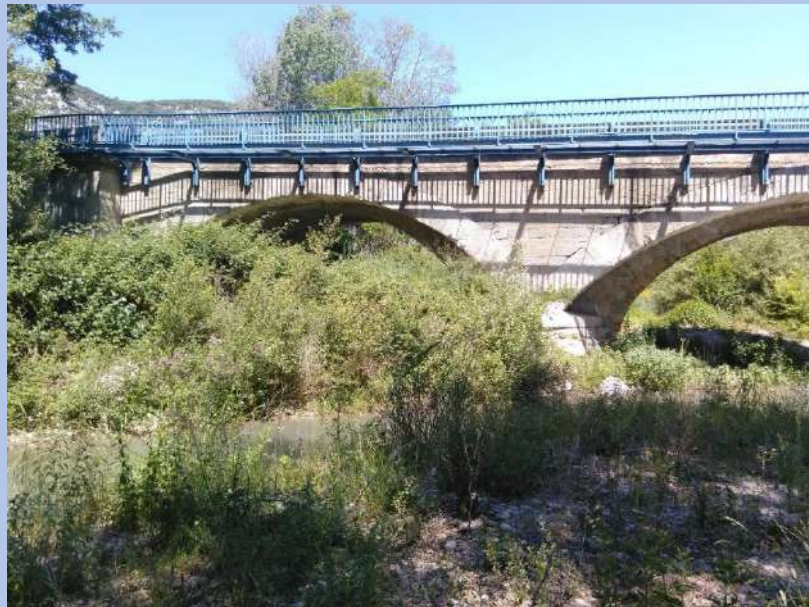
Figure 4 : vue de l'atterrissement sous le pont en rive droite (printemps 2022)
